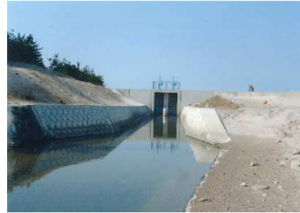
海岸保全施設（日光地区）
