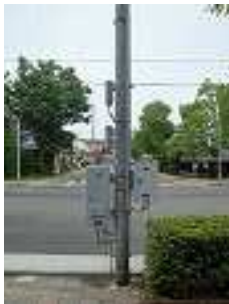
交通信号機（制御機）
