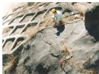
▲ 法面の剥落等（南部町） 出典：鳥取県県土整備部資料
