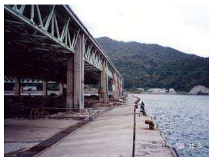
▲ 岸壁の破損（境港市） 出典：鳥取県ホームページ
