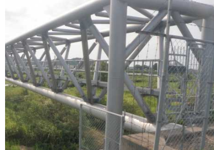
水管橋（鳥取工水）
