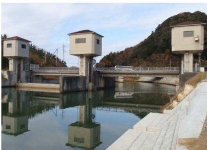
水門（塩見川潮止堰）
