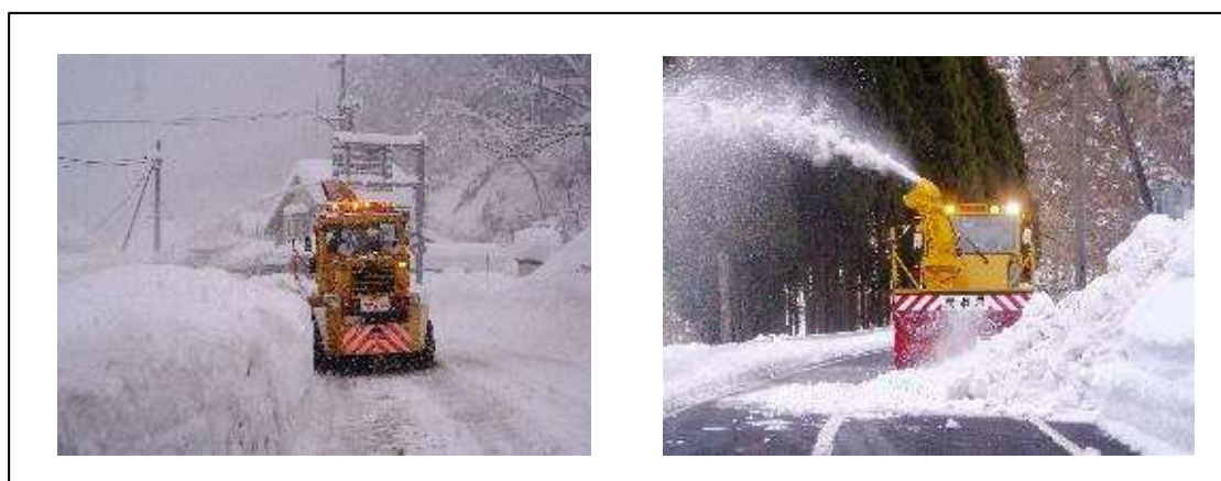
図3.5 鳥取県の除雪状況
