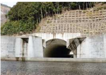
河川トンネル（市瀬トンネル）
