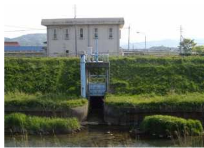
排水機場（西大路排水機場）
