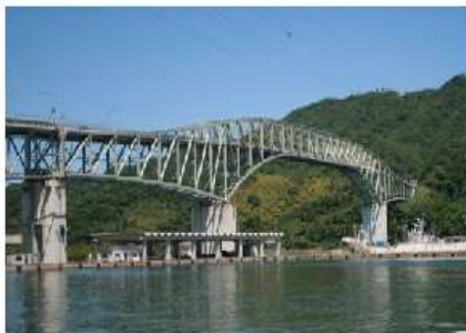
橋りょう（国道431号 境水道大
