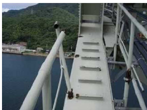
▲ 監査路の腐食・破断状況
