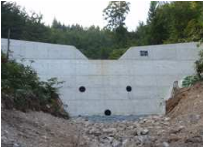
治山ダム（谷止工）（久連地区）
