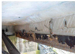
▲ 主桁の損傷状況
