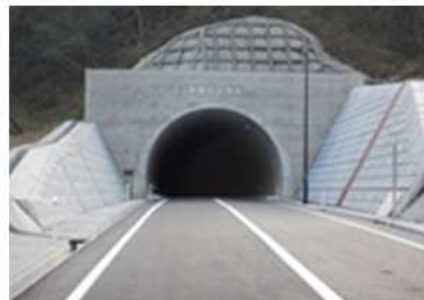
トンネル（日野溝口線 矢倉トンネ
